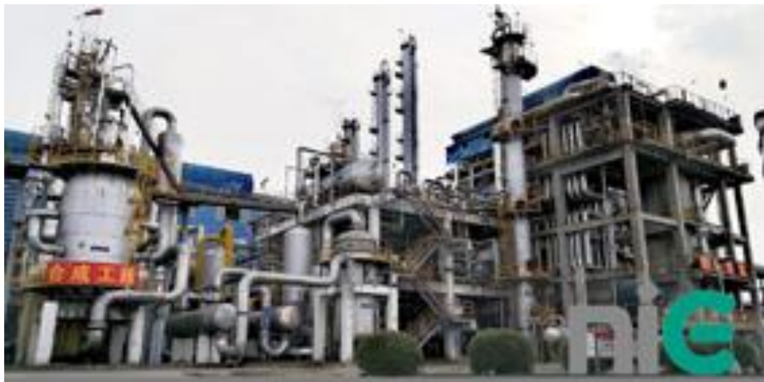
图为低碳院 MC17 催化剂在年产 12 万吨甲醇装置上实现首次工业应用
