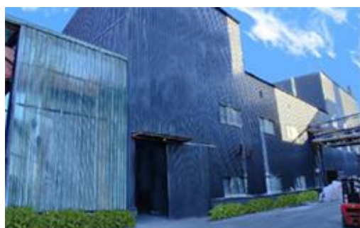
硫酸钠制纯碱示范工程厂房
